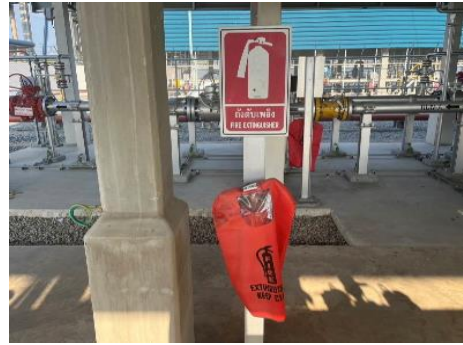
รูปที่ 2-9 ถังดับเพลิงชนิดผงเคมีแห้ง
